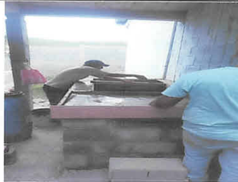
Foto 2: Construccion de Pila con 2 lavaderos.
