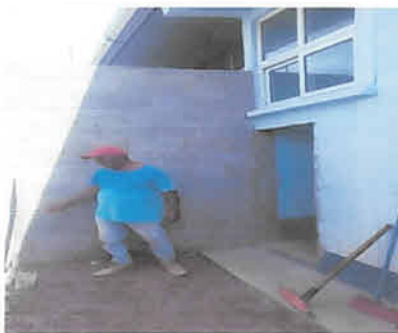
Foto 5: Levantado de pared de block y losa de bodega.
