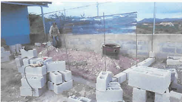
Foto 3. Levantado de bordillos de block de cocina.
