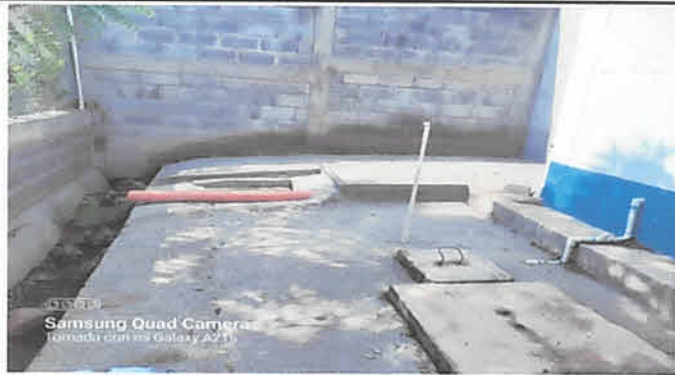
Foto 1: Instalacion de tuveria en patio para caidas de aguas pluviales
